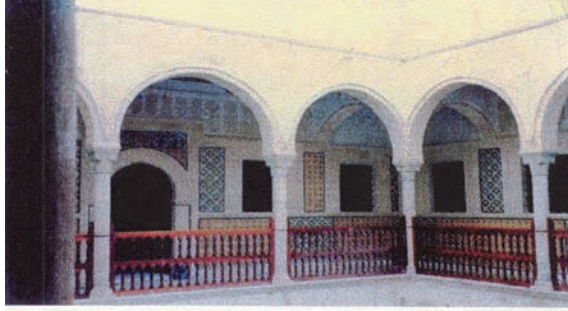
صورة (3) جزء من الفناء الداخلي لحوش القرماتلي
