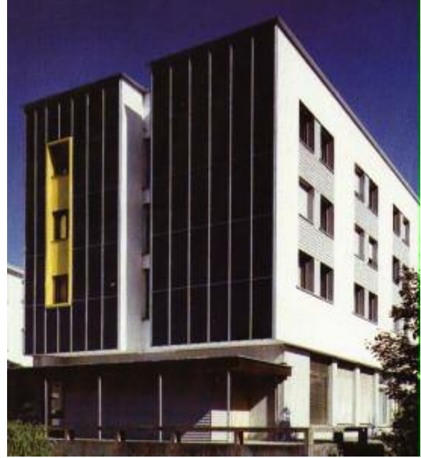
تركيب منظومات الخلايا الشمسية في الواجهات
