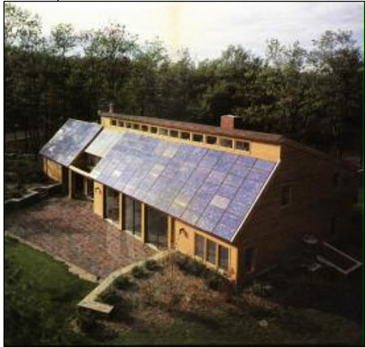
تركيب منظومات الخلايا الشمسية فوق أسطح المباني
