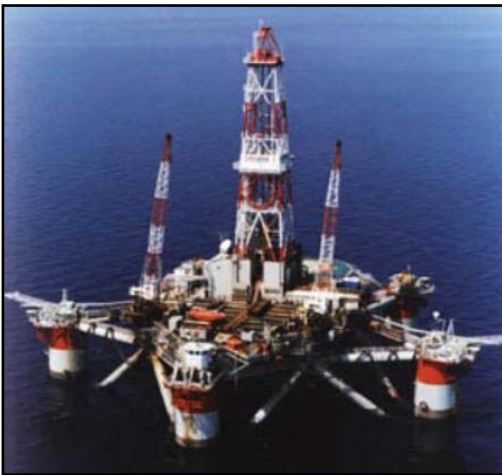
حفر آبار المنصة البحرية صبراته
