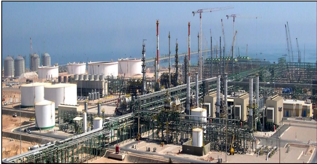
معمل مليئة لمعالجة الغاز البحري
