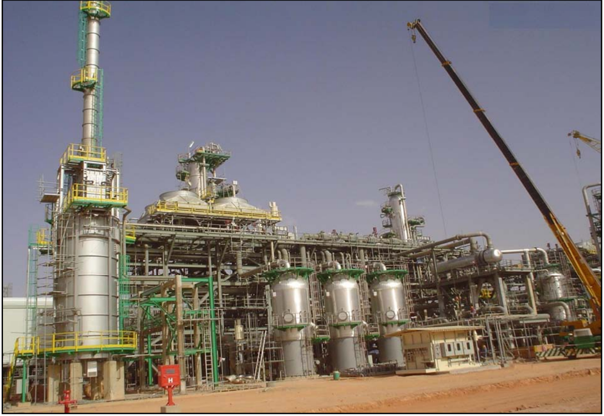
وحدة معالجة الغاز بحقل الوفاء
