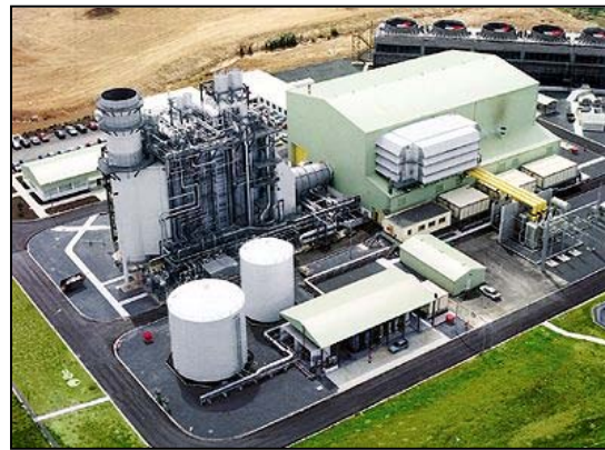
شكل (1) محطة توليد كهرباء تقليدية
